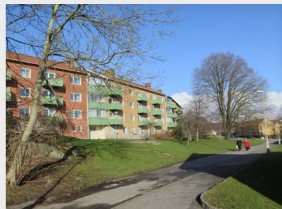
Kv Armeringsjärnet, Dörrspegel: Flygradiogatan
