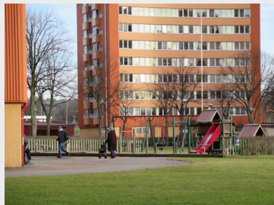
Kv Betongpålen: "Lösommarna"
