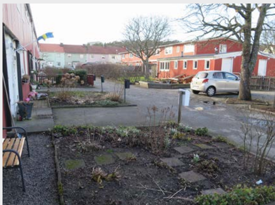
Kv Hanbjälken, Elektrongatans radhus
