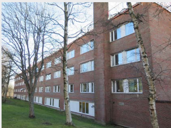
Kv Panelen: Toftaåsens sjukhem
