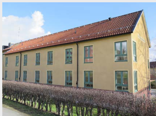
Kv Cementen: huvudbyggnad
