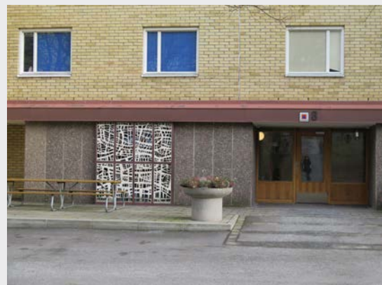
Kv Panelradiator, Garderoben, Skjutfönstret
