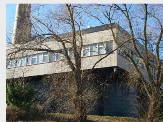
Panncentral, Järnbrott 12:1, Televisionsgatan 4
