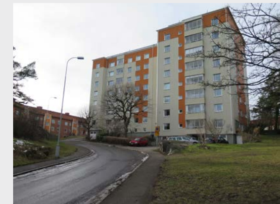
Saxofongatan, Kv Taket
